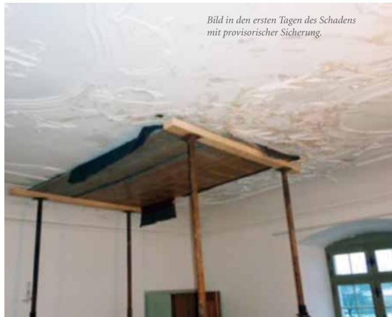
*Bild in den ersten Tagen des Schadens mit provisorischer Sicherung.*
